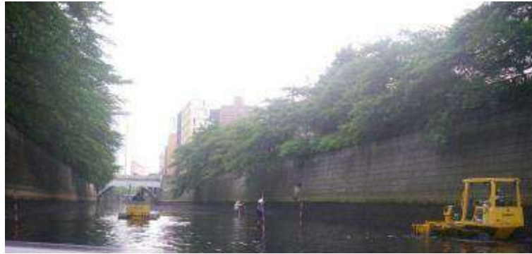
写真 5 河床整正の様子
