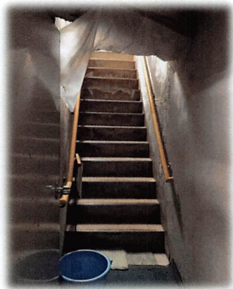
【ホール】 地下の水漏れ
