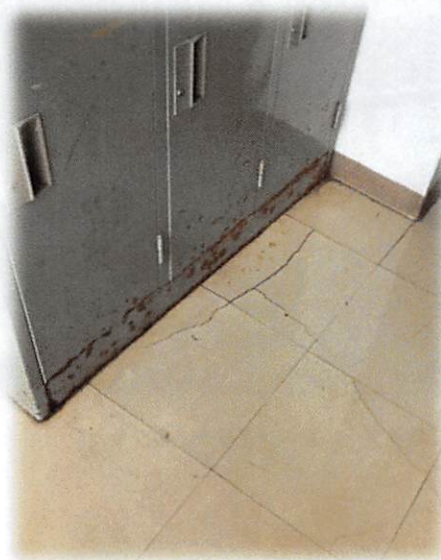
【ホール】 楽屋床材のクラック
